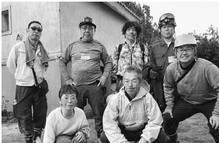
これから泥・瓦礫のかき出し撤去作業! 頑張ります!
